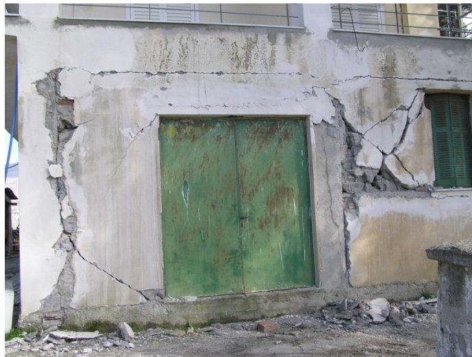
Εικόνα 4. Διώροφη οικοδομή στον Αγ. Δημήτριο βορείως του Ληξουρίου μετά τον πρώτο ισχυρό σεισμό της 26.1.2014.
