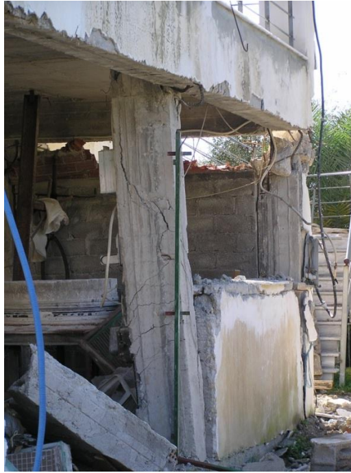
Εικόνα 5. Η δώροφη οικοδομή της Εικ. 4 μετά τον δεύτερο ισχυρό σεισμό της 3.2.2014.
