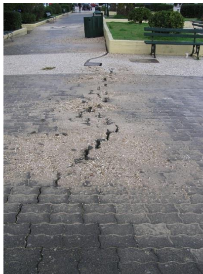
Εικόνα 16. Επιφανειακή εκδήλωση ρευστοποίησης τεχνητής επιχωμάτωσης κατά μήκος θραύσης στην προβλήτα του λιμανιού του Ληξουρίου εξαιτίας του δεύτερου σεισμού.
