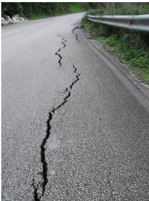
Εικόνα 14. Θραύση οδοστρώματος εξαιτίας του πρώτου σεισμού.
