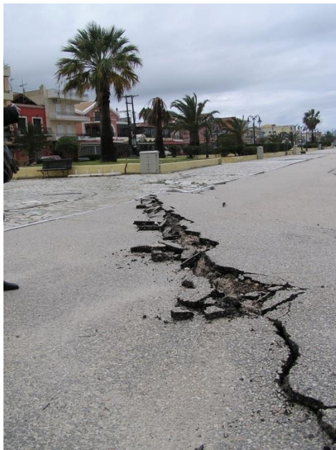
Εικόνα 8. Η θραύση της προβλήτας στο νότιο τμήμα του λιμανιού στο Ληξούρι (Εικ. 5), όπως διευρύνθηκε μετά τον δεύτερο ισχυρό σεισμό.
