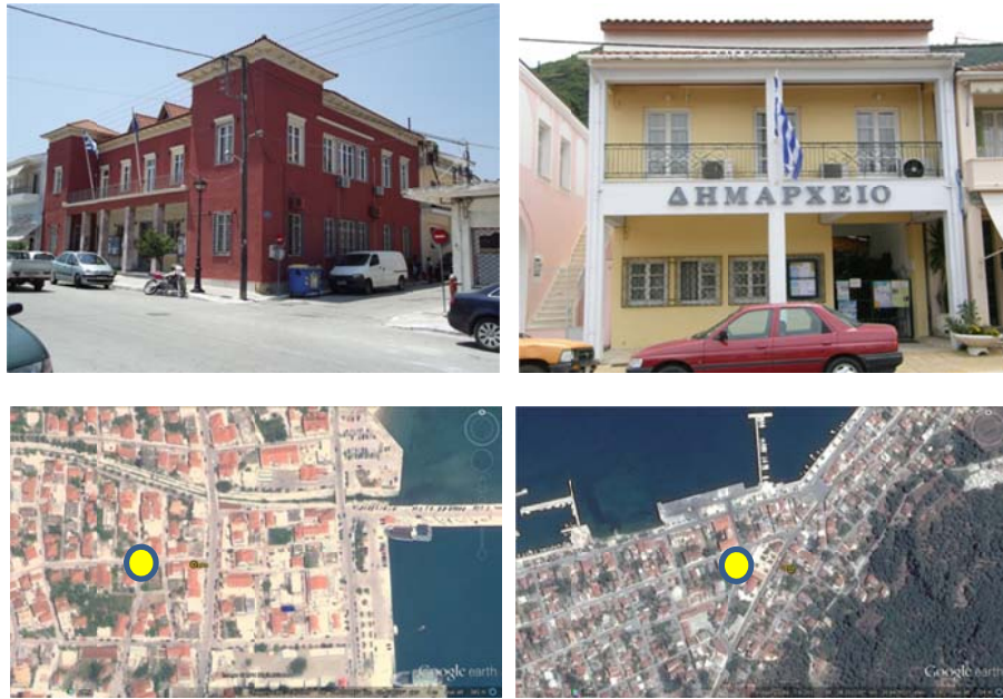
Εικόνα 2. Τα κτήρια των δημαρχείων Ληξουρίου (πάνω αριστερά) και Σάμης (πάνω δεξιά) όπου είναι εγκατεστημένοι οι δύο επιταχυνσιογράφοι και οι αντίστοιχοι χάρτες των πόλεων με σημειωμένες τις θέσεις εγκατάστασης.
